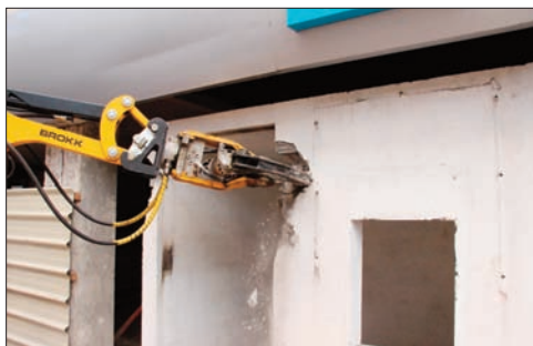
Il suffit d'appuyer sur un bouton pour détruire un bloc de béton de 32 cm d'épaisseur.
