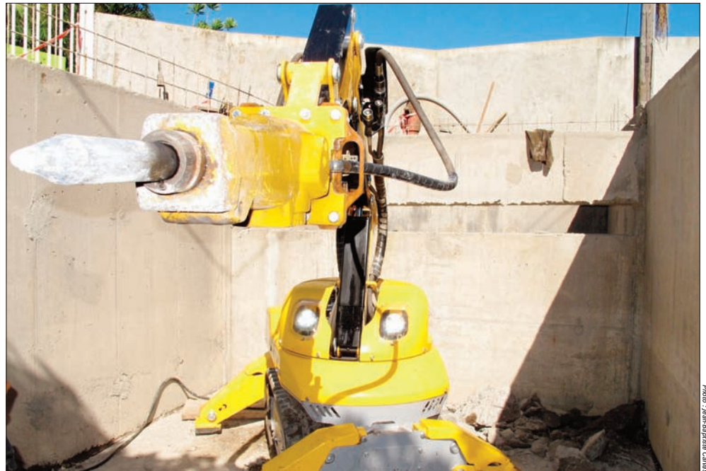
Il pèse près d'une tonne, mais le robot se révèle très maniable et permet de faire le travail de plusieurs hommes.
