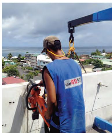
Au dernier étage d'un immeuble à Arue, un particulier a décidé de transformer son garde-corps en béton armé en verre. MD BAT est intervenue pour scier ledit garde-corps en différents blocs et les évacuer (la grue ci-contre permet de déplacer des blocs de 600 kilos).
